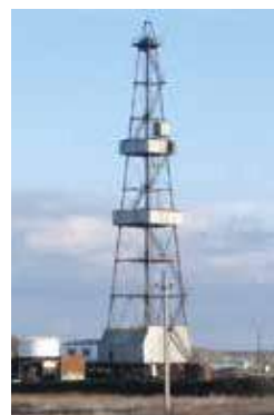
Нефтяная вышка в Восточном нефтегазоносном регионе
